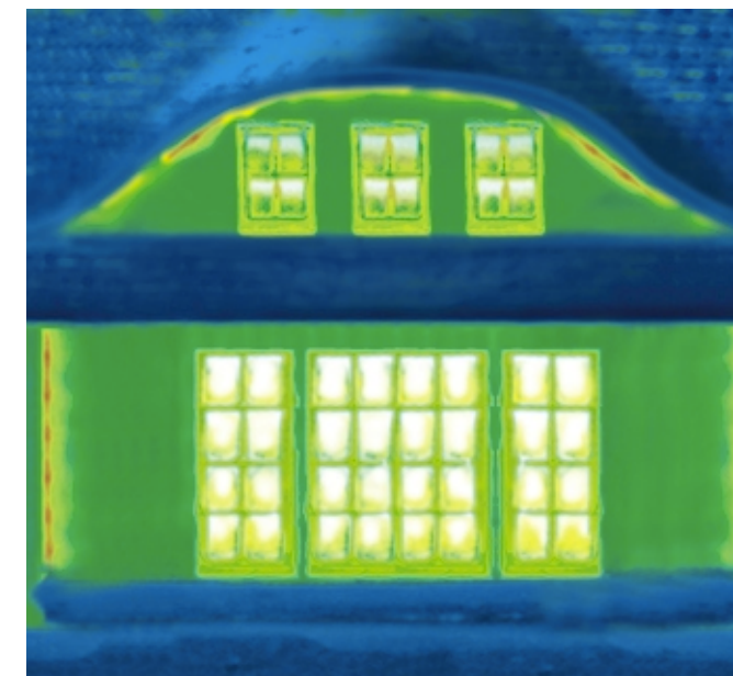
După renovare: pierderi energetice minimizate prin folosirea profilelor GENEО®.
